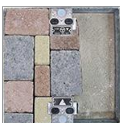
▲ Ocelový poklop, s možností vydláždění
