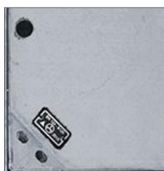
▲ Ocelový poklop, vybetonovaný
